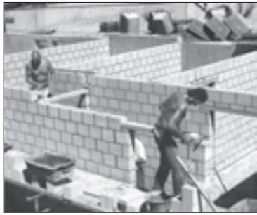
Rege Bautätigkeit, verursacht durch starke Zuwanderung infolge freiem Personenverkehr.
