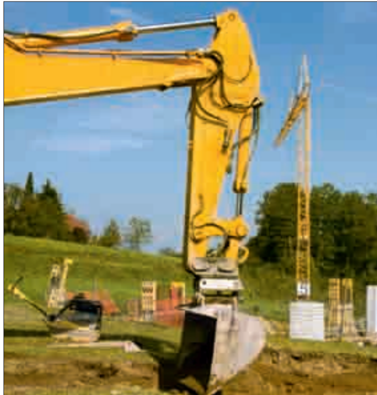
Und ewig droht der Baggerzahn...
